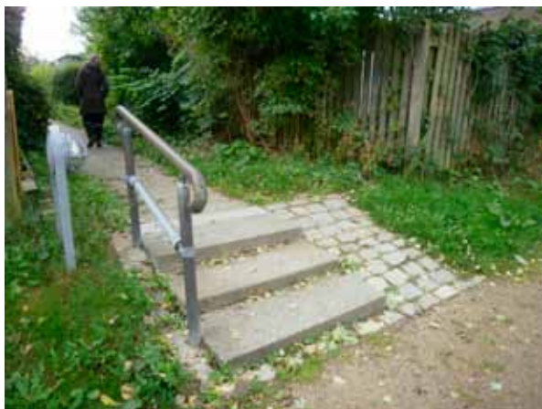
Før var der trapper og rampe
