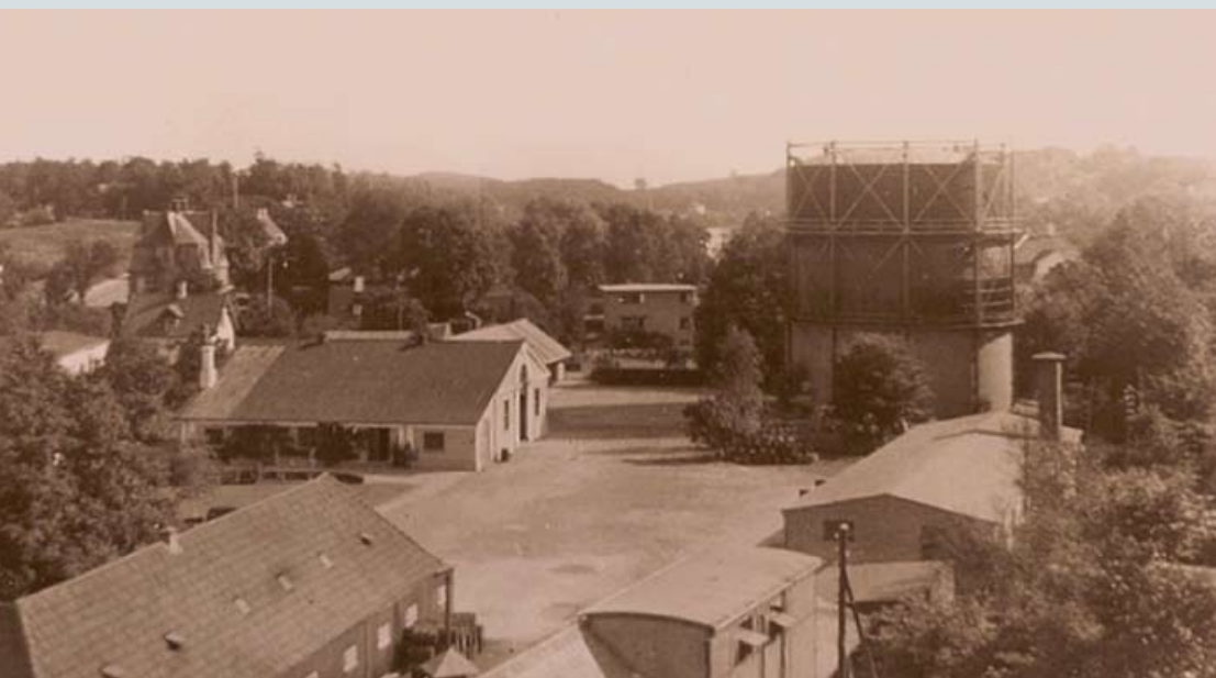
Søllerød Kommunes Gasværk anno 1950. Dengang fandtes over 100 gasværker som dette i Danmark. På hvert gasværk opstod som biprodukt i gennemsnit omkring 300 tons kultjære om året.
